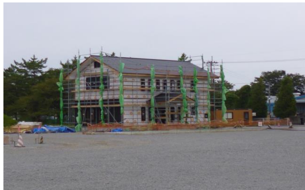
(管理棟建設状況)
