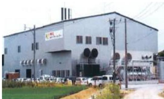
発電プラントは木質バイオマスガス化発電方式で、アップドラフト式のガス化炉で木質バイオマスを不完全燃焼させて可燃性ガスを取り出し、ガスエンジンを燃焼駆動して発電するものであります。含水率が 40~50% のチップでも炉に投入できるため、チップの乾燥施設が不要となります。24 時間連続で運転し、年間 310 日程度稼働で発電量約 1,480 万 kw 時となり、これは一般家庭約 3,000 世帯分に相当します。
